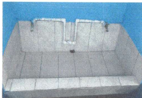
Foto 8: sustitución de llave de chorro y azulejo en lavamanos
