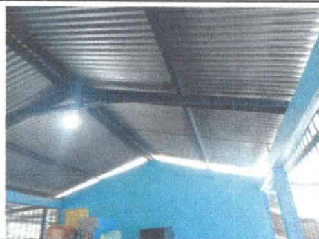
Foto 10. Reparación del cableado eléctrico en módulo dos
