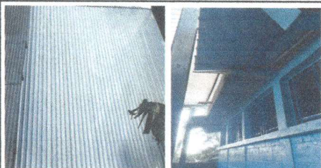
Foto 1: sustitución de lámina por lámina troquelada aluzinc, calibre 26 con capote de lámina en baños
