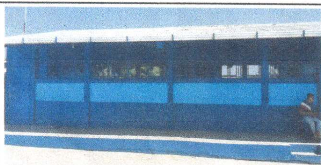
Foto 5. Pintura en muros exteriores del módulo uno, dos, tres y baños
