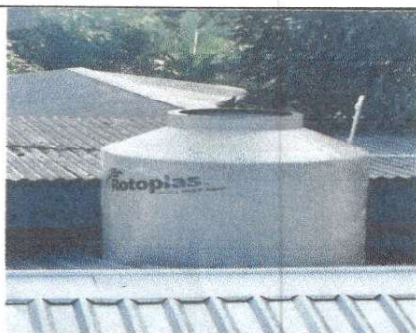
Foto 11. Sustitución de depósito de agua.
